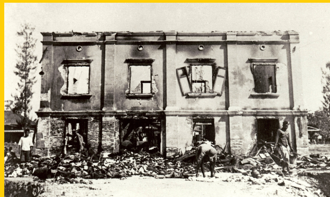
คลังयरภักดิ์ ส. พัน 9 ถูกเครื่องบินฝ่ายสัมพันธมิตรทิ้งระเบิดจนเหลือแต่ซาก
