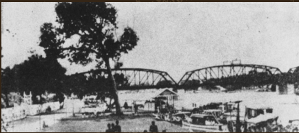
แม่จันทรรักษ์ เป็นช่างไม้รับทำสะพานที่ บ้านควน 2440 เมื่อเริ่มมีสะพานรถไฟข้ามแม่น้ำ
