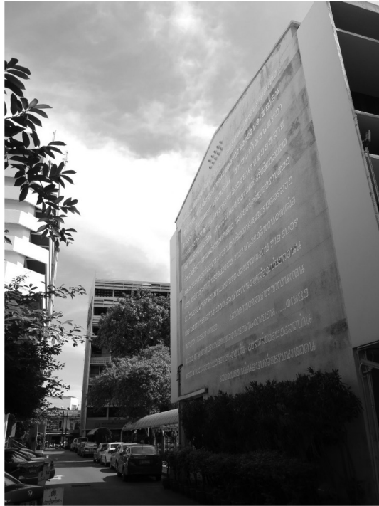
อาคาร ๓ ชั้น คณะศิลปศาสตร์ด้านที่ติดลานปรีดี
