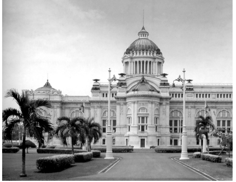
ภาพที่ 2 พระที่นั่งอนันตสมาคมมีการประดับโดมกลมเหนือหลังคา ที่มาภาพ: เพ็ญสุภา สุขคตะ ใจอินทร์, อลังการสถาปัตยกรรม 200 ปีกำแพงเมืองเก่า, (กรุงเทพฯ : เชนเนอรัลเอนจิเนียริง, 2548), 89.
