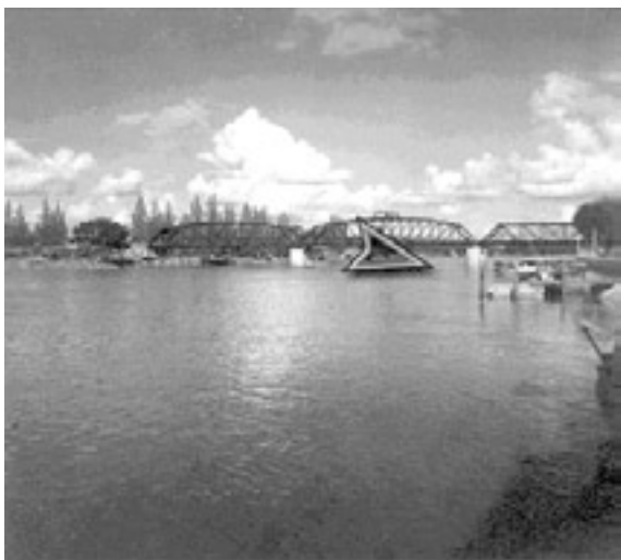
ภาพสะพานจุฬาลงกรณ์ตรงลูกศรชี้คือจุดที่ห้วงจักรไอน้ำ ลูกระเบิดขนาด 1000 ปอนด์ 3 ลูก รางรถไฟ 2 ชั้น ล้อรถจักร 1 ชั้น จมน้ำอยู่
