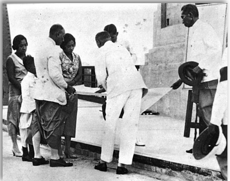
รัชกาลที่ 7 เสด็จพระราชดำเนินตรวจการก่อสร้างสะพานพระพุทธรยอดฟ้า ด้านขวา คือ สมเด็จพระเจ้าบรมวงศ์เธอ เจ้าฟ้าฯ กรมพระยานริศรานุวัดติวงศ์
