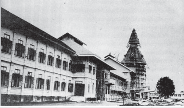
ดึกโดมขณะกำลังก่อสร้าง
