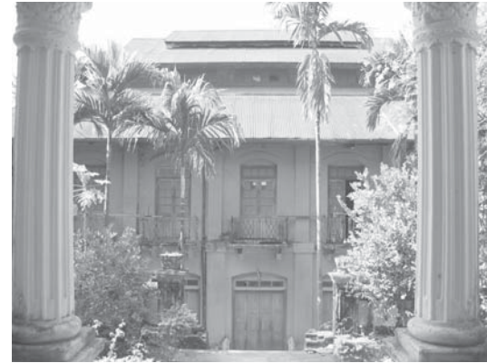
อาคารภายในวัดเชิงเขาพระเจติยมยะตะเบ็ต (Myathabeik Paya) สถาปัตยกรรมแบบอาณานิคม ที่เมืองสะเทิม
